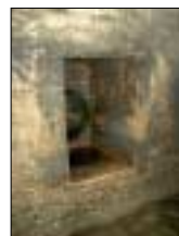
Il condotto d'ingresso
